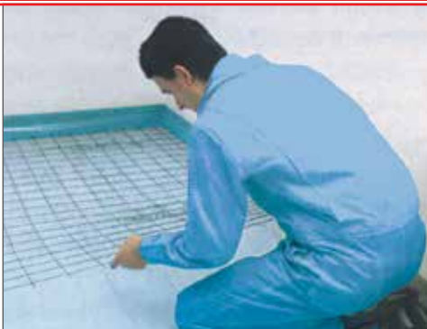
Etendue de la grille métallique du support, superposer les feuilles minimum 10 cm.
