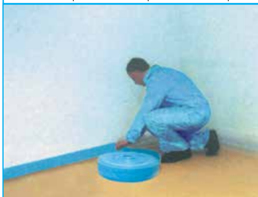
Fixation de la bande périphérique avec une feuille en PE soudée.
