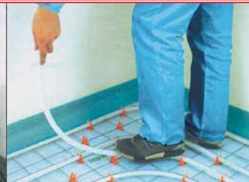
Pose du tube sur les agrafes précédemment fixées sur la grille métallique.
