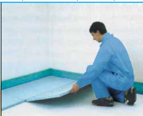
Pose des panneaux isolants.
