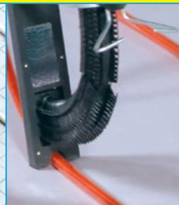
Fissaggio del tubo sulle lastre isolanti, mediante sparatura delle graffette fermatubo.
