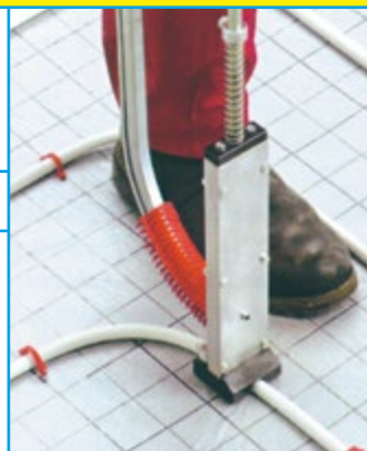
Fissaggio del tubo sulle lastre isolanti, mediante sparatura delle graffette fermatubo.
