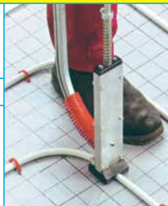
Fixação do tubo nas placas isolantes, através de aplicação das grampos de fixação de tubo com agrafador.
