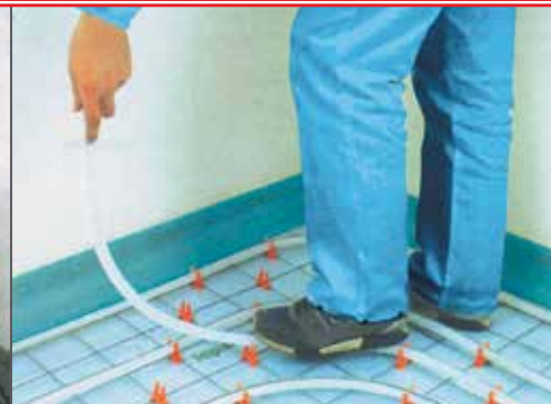
Montarea țevii pe clemele fixate anterior pe plasă
