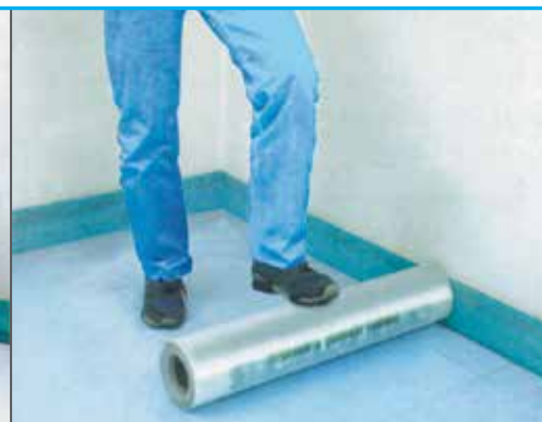
Așezarea foliei de protecție din PE, grosime minimă 0,15 mm, cu suprapunere la margini.
