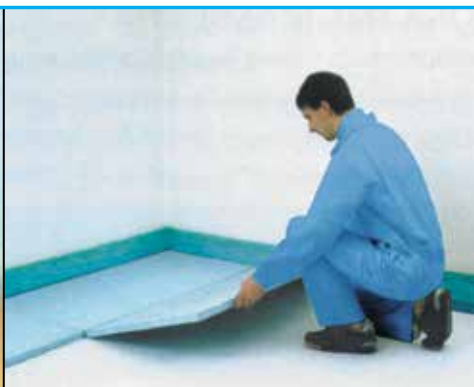
Montarea panourilor izolatoare
