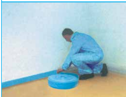
Fixarea benzii perimetrale cu folie de PE sudată.
